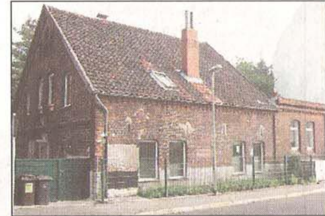
VORHER: Das Haus vor dem Umbau.
